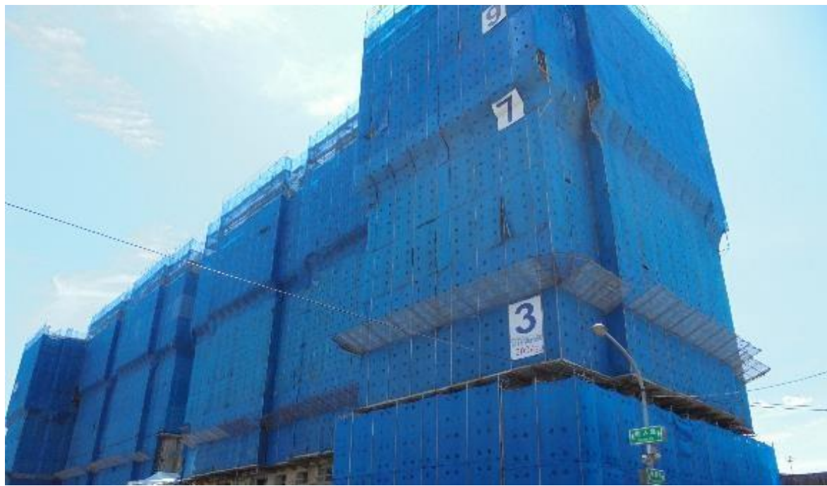
覆蓋防塵網 架設斜籬
