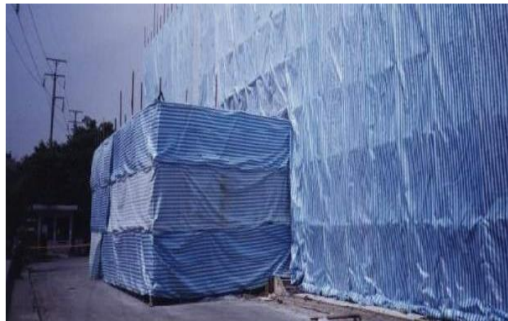
於結構體包覆防塵布
