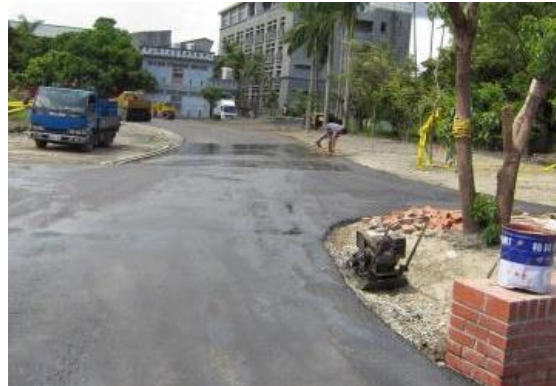
鋪設瀝青混凝土
